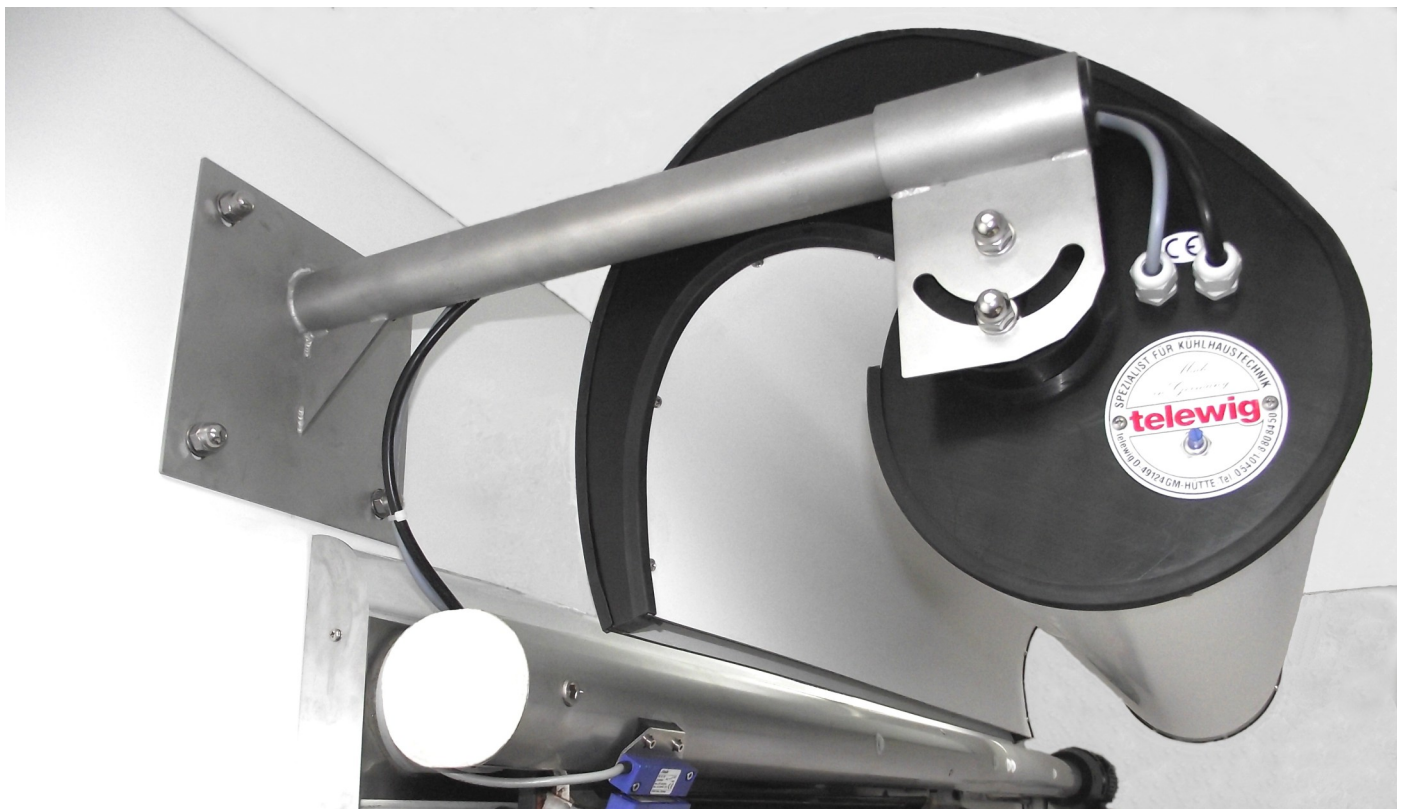
Luftschleieranlagen-Luftstrom bei einer Drehtür
